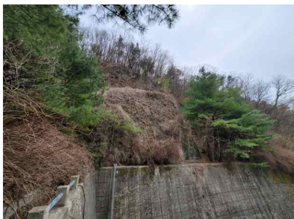
옹벽, 사면부 전경
