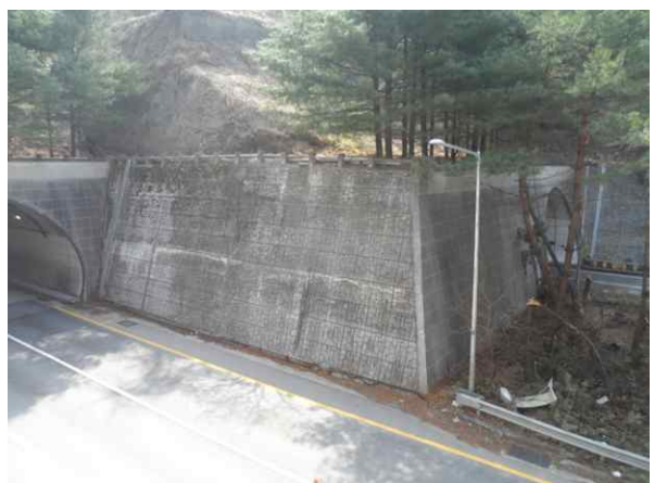
옹벽, 사면부 전경
