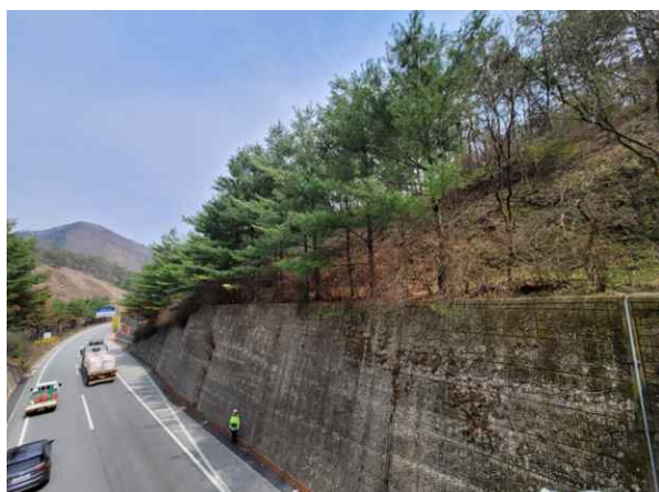
옹벽, 사면부 전경
