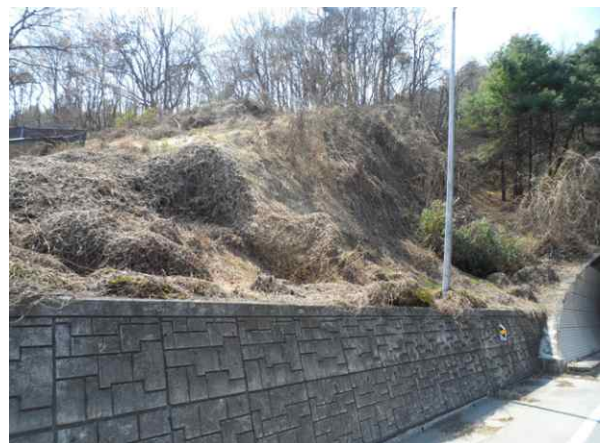
옹벽, 사면부 전경
